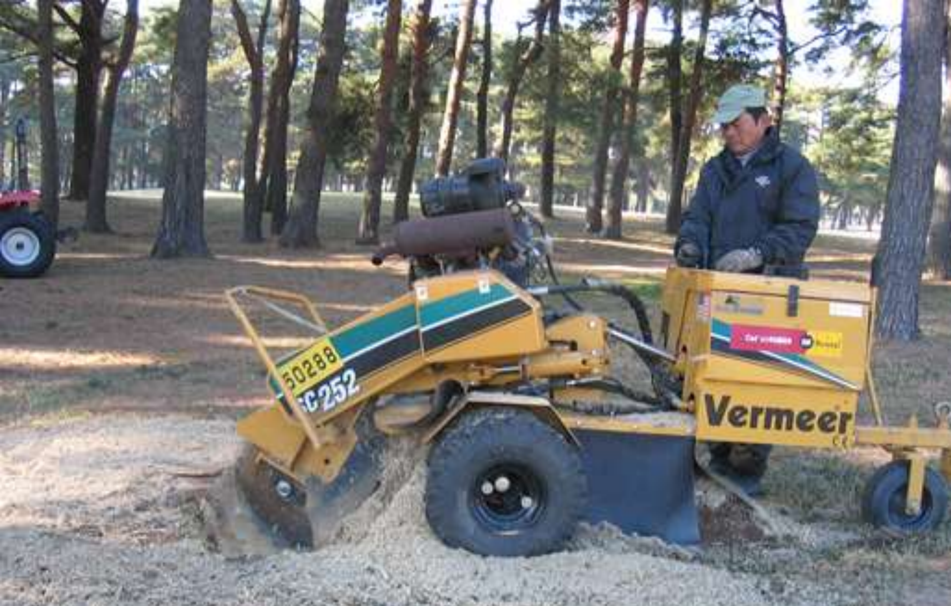
専用の機械による切り株の処理:茨城GC
