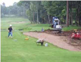
平川カントリークラブの改修風景。
