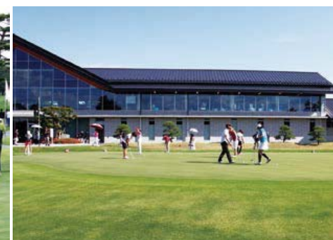
新築のモダンなクラブハウス。
