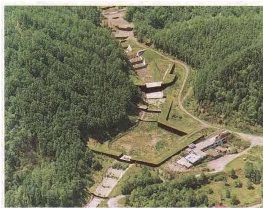
E-2 扇頂部に施工された砂防施設
