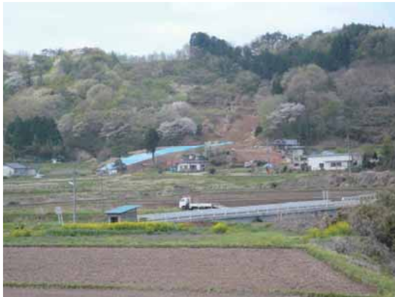
神長地区の崩壊地全景
